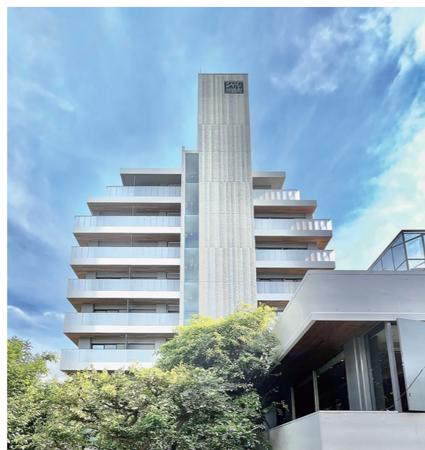
「シャトレ信濃町」(東京都新宿区、2022年竣工)
