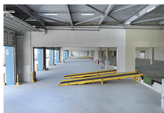
45ftコンテナ車両対応トラックバース
