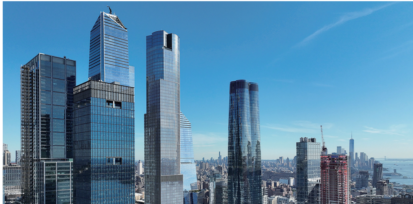
ハドソン川から見たハドソンヤード(米国・ニューヨーク) 左から1棟目:50ハドソンヤード 2棟目:55ハドソンヤード
