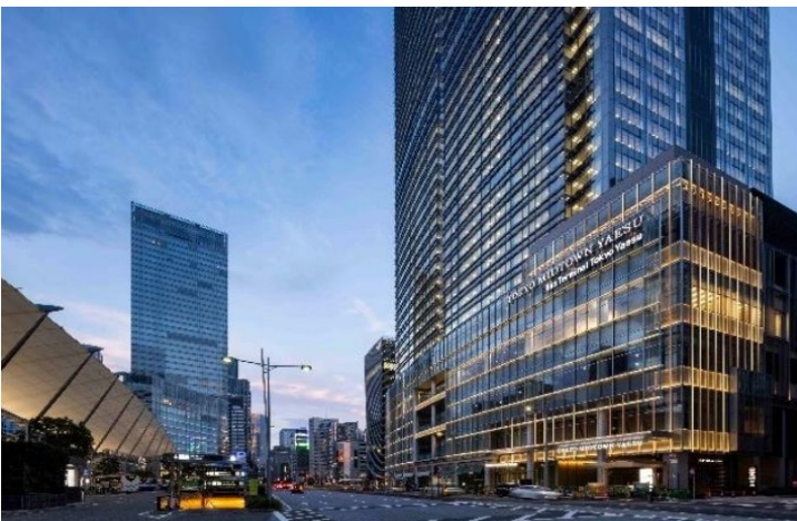
外観写真（低層部）
