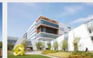
三井不動産 ロジスティクスパーク船橋Ⅲ (MFLP船橋Ⅲ) 千葉県船橋市(2021年6月竣工)
