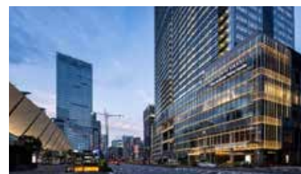
東京ミッドタウン八重洲(グリーン電力導入)
