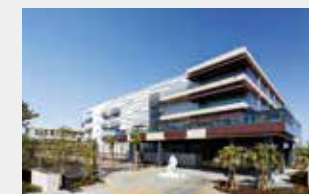
三井不動産 ロジスティクスパーク市川塩浜Ⅱ (MFLP市川塩浜Ⅱ) 千葉県市川市(2022年3月竣工)
