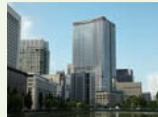
「日比谷通り側外観」
