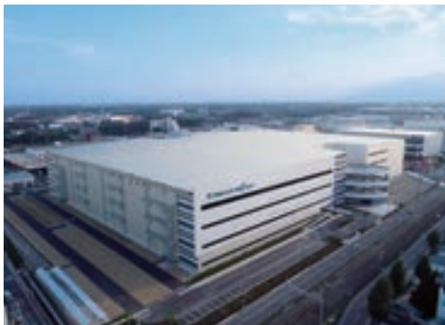
「MFLPプロロジスパーク川越」(埼玉県川越市)
